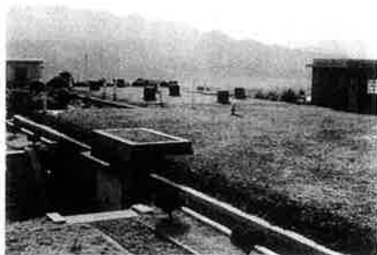
第一配水池 (『市勢要覧』1961年より引用)
