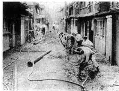
水道工事（池船地区） （『佐伯市史』より引用）
