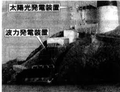
ハイブリッド電源システムが完成した水ノ子島灯台(上)と両発電装置＝大分航路標識事務所提供
