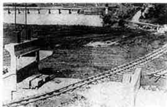
池田地区の捷水路工事 (昭和28年ごろ)
