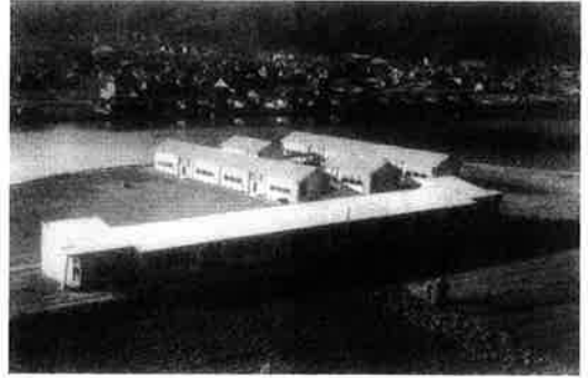
鶴谷中学校の新校舎(第一期新校舎)
