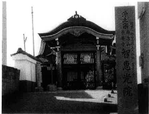
知恵光院 称念山平等寺といい、浄土宗の寺である。永仁2年(1294)鷹司家の始祖関白鷹司兼平が自家の菩提寺院として如空国師と開山に請じ創建したのが当院の起こりと伝え、のち、関益上人によって塔頭も整えられ京都七光院の一つとしてますます隆盛を極めた。(中略)本堂には本尊阿弥陀如来像を祀る。また小野篁作と伝えられる六臂地藏像を安置した地藏堂や弁財天を祀った小堂などがある。(京都市案内板)
