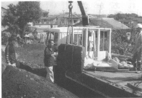
石棺移設作業②
