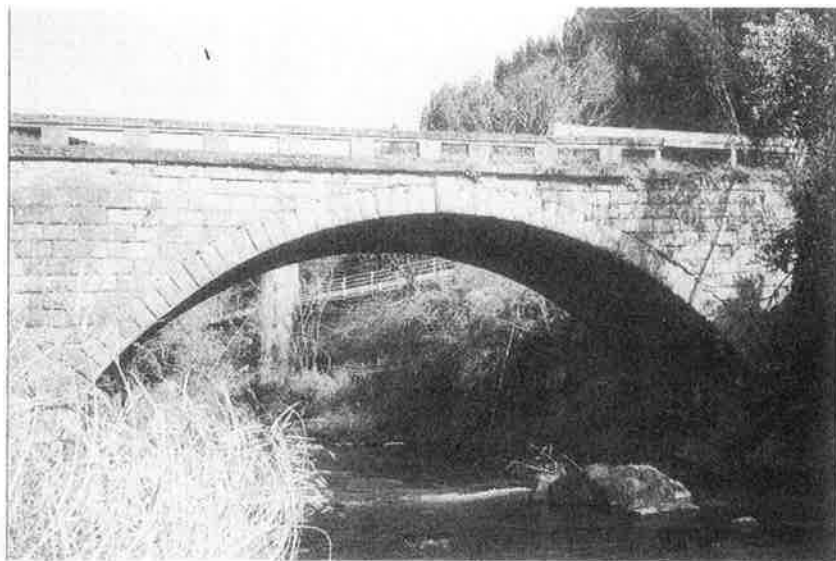
九重町 妙見橋
