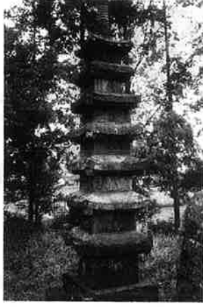
湯前浄心寺の七重塔
