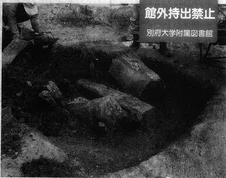
天祐館跡地から発掘された基礎部分
