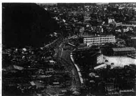
排水工事が完了したときの白坪川 帯状の構造物は排水溝(ボックスカルバート)
