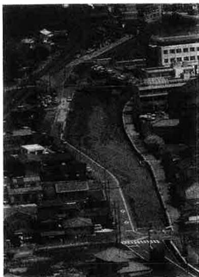
工事前の白坪川
