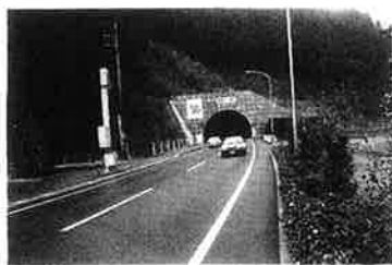
彦岳トンネル(平成6年3月)
