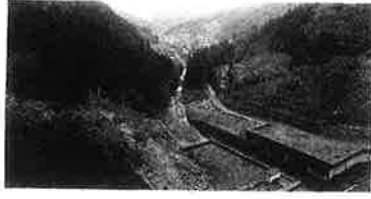
床木ダムより徳納を望む(平成6年3月)
