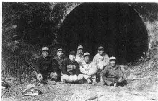
旧浦代トンネル 〔『米水津村誌』より引用〕
