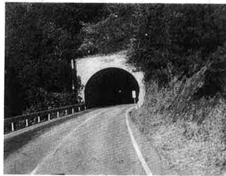
浦代トンネル (平成7年11月)
