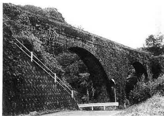
若宮井路笹無田石拱橋
