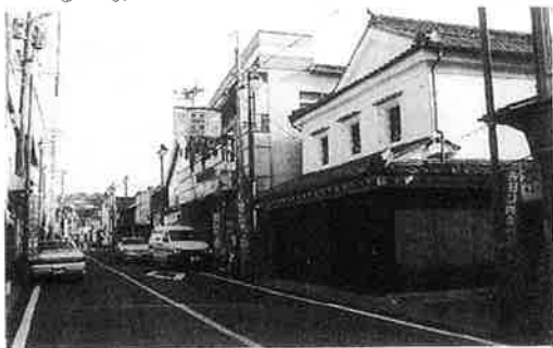
下本町 保存修理中の塩屋
