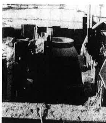
工事中のマンホール
