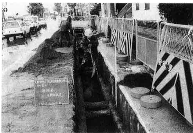
下水道の工事（『佐伯市総合計画』）平成元年12月より引用
