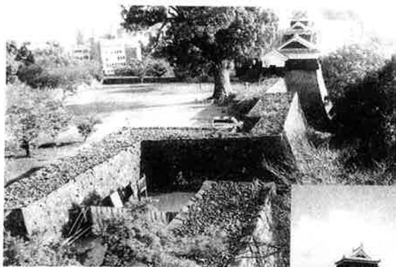
飯田丸五階櫓 （石垣上の栗石に注目）
