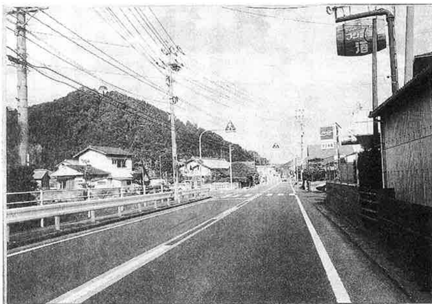
昔は宿屋や客馬車の駅があった江良(平成8年11月)
