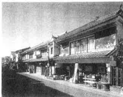
↑ 伝統的建築物 一丁目の町並み（右）
