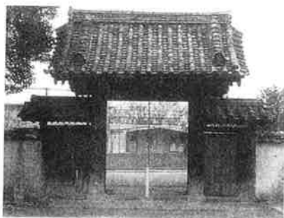
四日市陣屋 陣屋門
