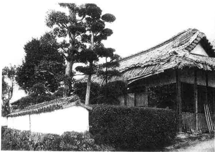
日出町深江の襟江亭。数奇屋書院・門・塀・石垣がセットで 実現する全国で唯一の御茶屋遺構。（平成15年2月撮影）
