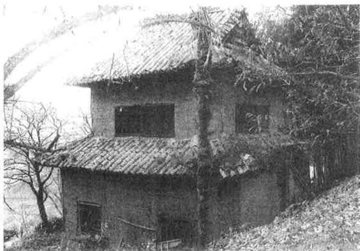
鬼門櫓の現況。鬼門である東北角（写真中央木の背後）を意図的に欠いた構造。（平成15年2月撮影）
