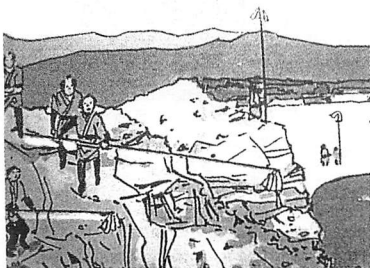
測量杭打ちと梵天位置指定
