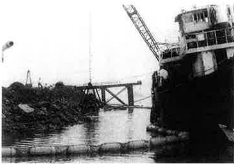
海に突き込んだ土砂をバケットでつかんで海水で洗って船積み
