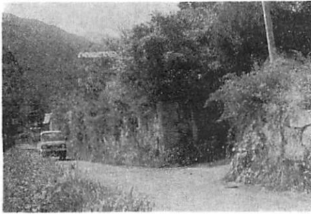
石垣な立派な屋跡庄口溝
