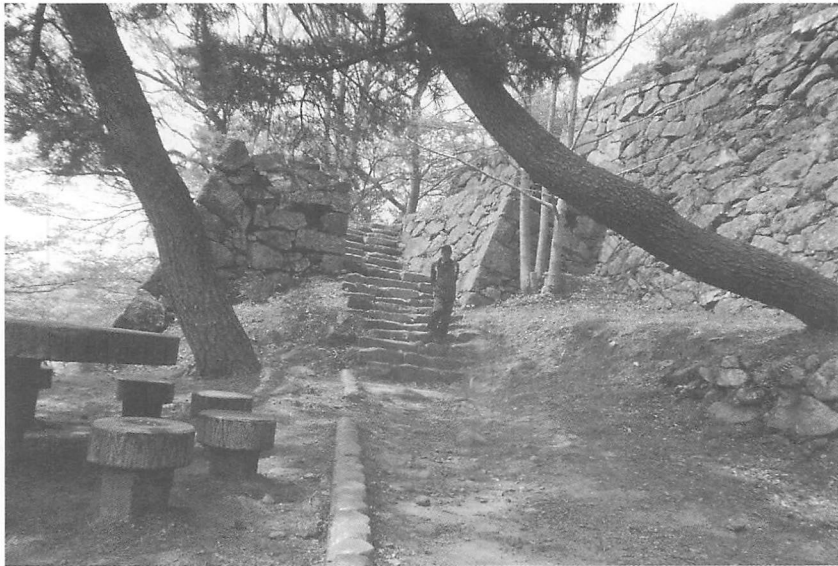
天守の横、海側にある望海樓の石垣跡
