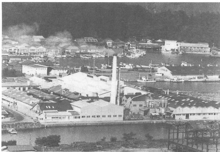
両陛下の行幸された二平合板本社工場
