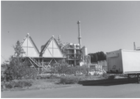
日田ウットパワー発電所（日田市東有田）
