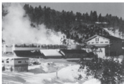
上の岱地熱発電所（東京電力）
