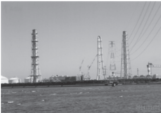
九州電力新大分火力発電所 (大分市青崎)
