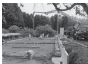
Y地熱発電所の工事現場・全景
