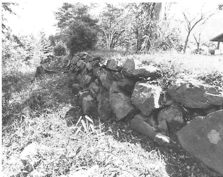
平田城の南側石垣（南台）
