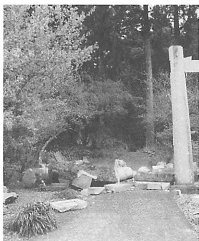
地震により倒壊した鳥居 (平成28年4月16日撮影)
