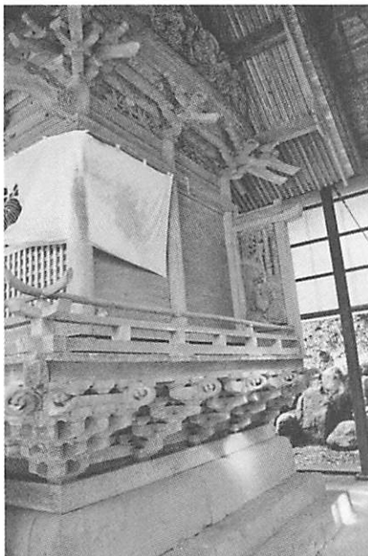
地震の強い揺れに耐えた建築物 （霧島神社本殿）
