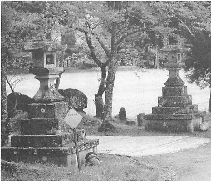
地震で外れた石造物の頭部 （東側参道入口にて） （4月22日撮影）
