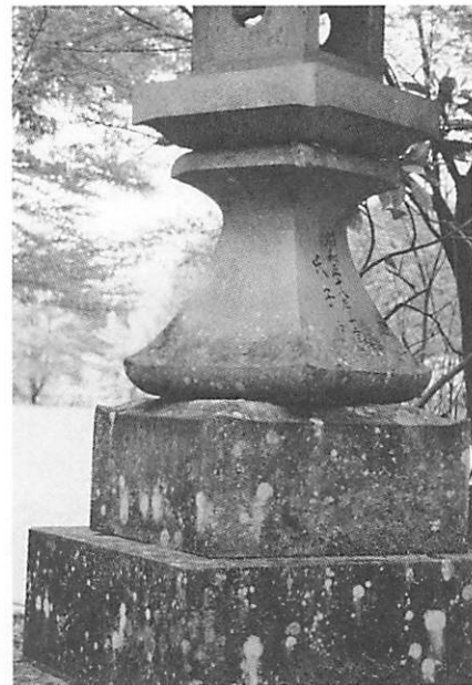
地震で一部がずれた石造物 （北側参道にて）
