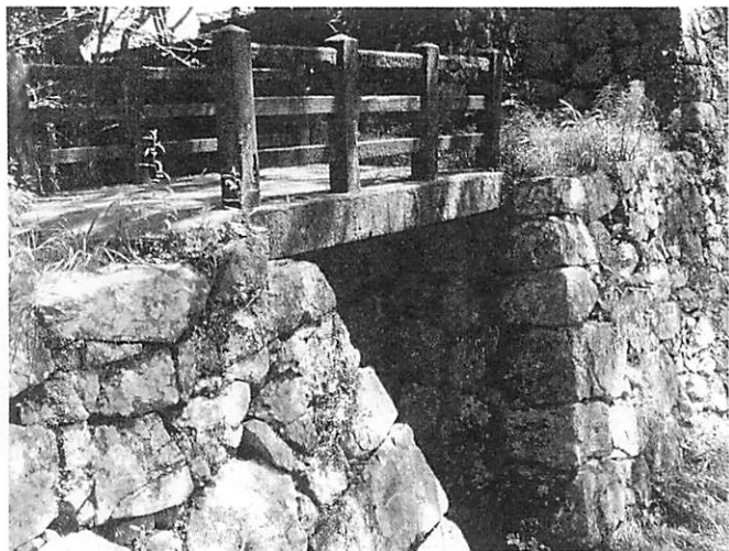
本丸から二の丸への通路として廊下橋がある。この橋は敵が攻めてきた場合、切り落とす仕組みである。
