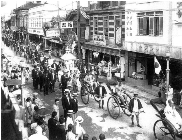
永野清市長の葬列(流川通り 弔旗を掲げている)
