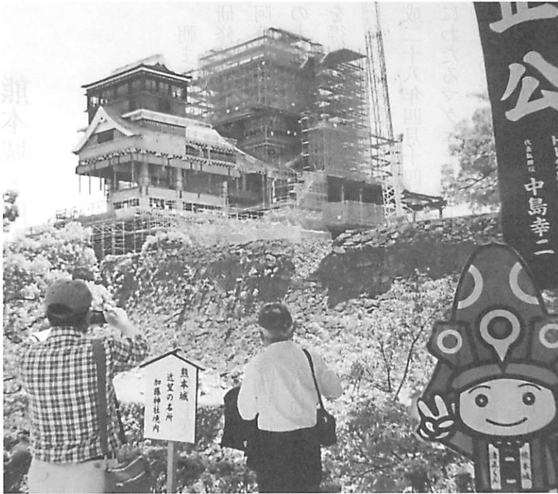
修復中の熊本天守
