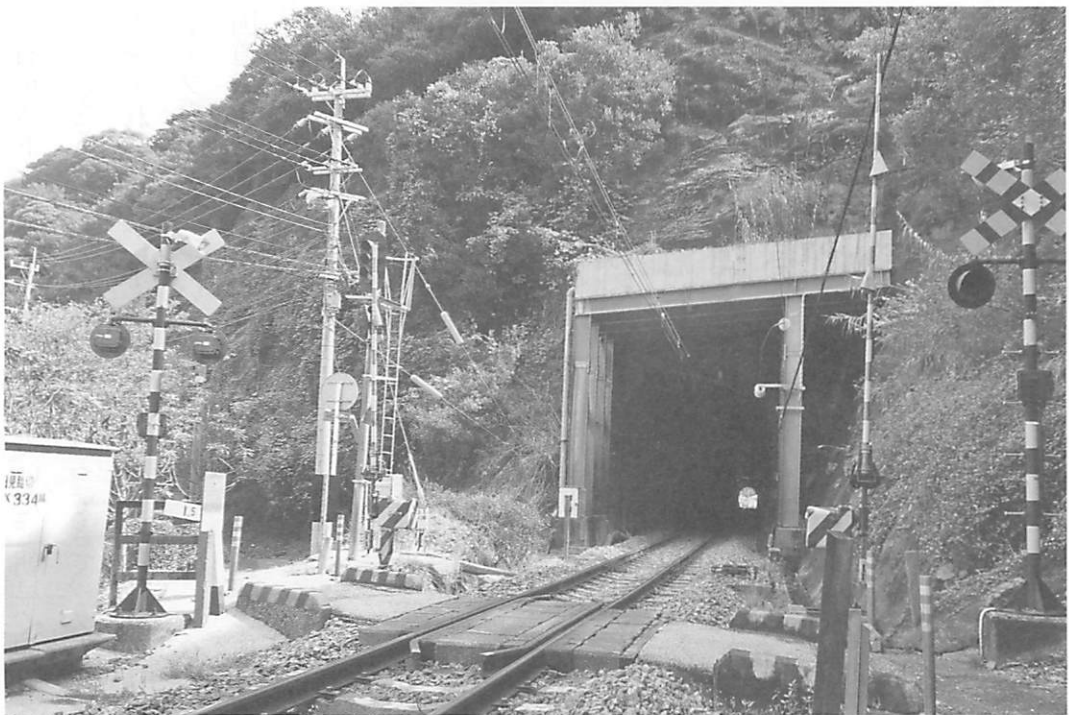
日代駅一日見間にあるトンネルとたった一つの踏切
