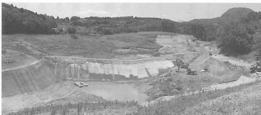
工事中の放生池
