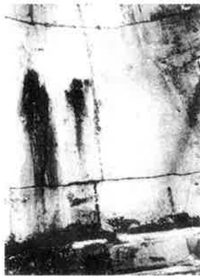
丹賀砲台壁面 平成一六年六月撮影
