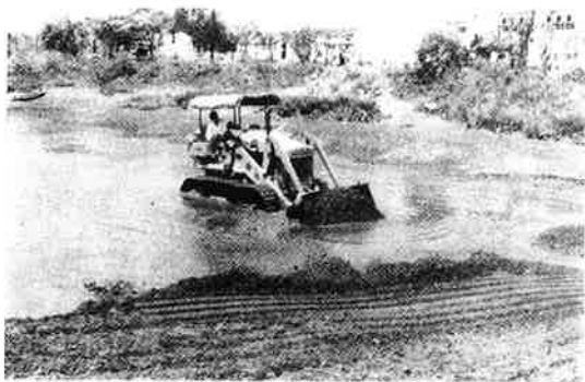
城南橋付近の河床均（『工事完了記念誌』昭和53年）
