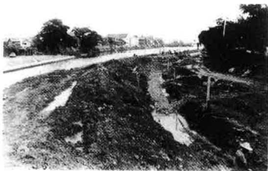
城南橋付近の側溝工事（『工事完了記念誌』昭和53年）
