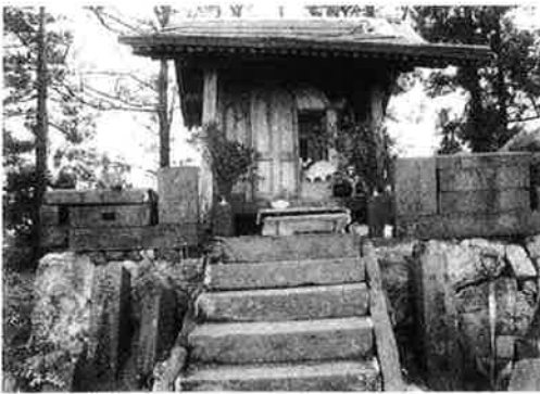
改修前の彦嶽神社本殿
