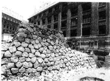
写真1 通路部分の石垣③
