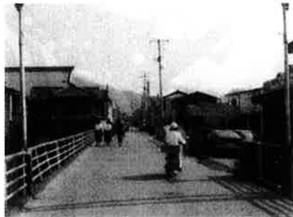
④池船橋より(施工前)
