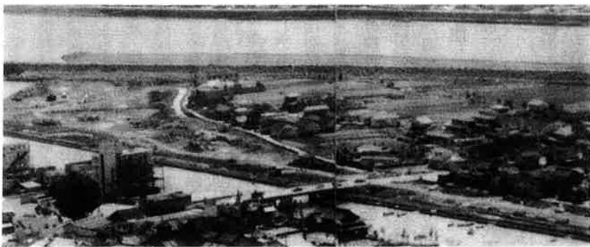
①城山から見た池田第二地区(施工前・昭和51年10月28日)左
