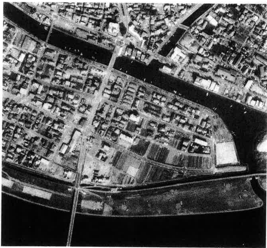
①施工後の全景写真（『池田第二土地区画整記念完成理事業』による）
