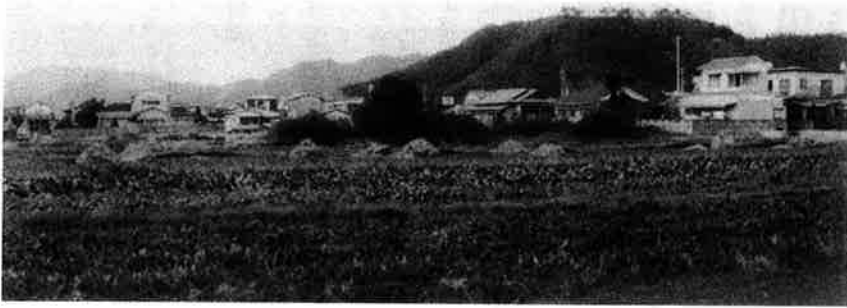
②番匠川堤防より（施工前）
